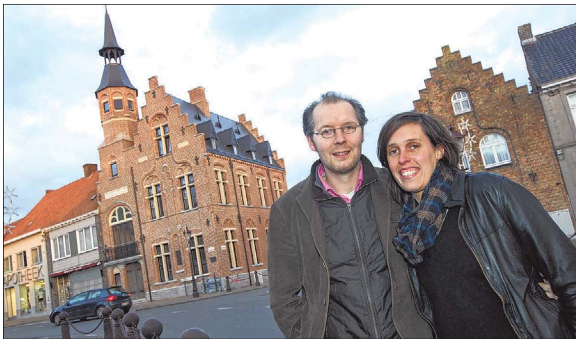
Een jaar geleden kochten Charlotte Pattyn en Thomas Theunynck het oude gemeentehuis op het Handzameplein. De verbouwingen aan het gemeentehuis zijn ondertussen volop aan de gang. (Foto Kurt)
